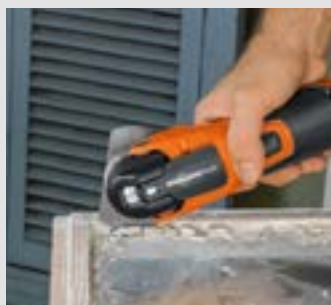
Durch Oszillationsbewegung keine Glasbruchgefahr.
